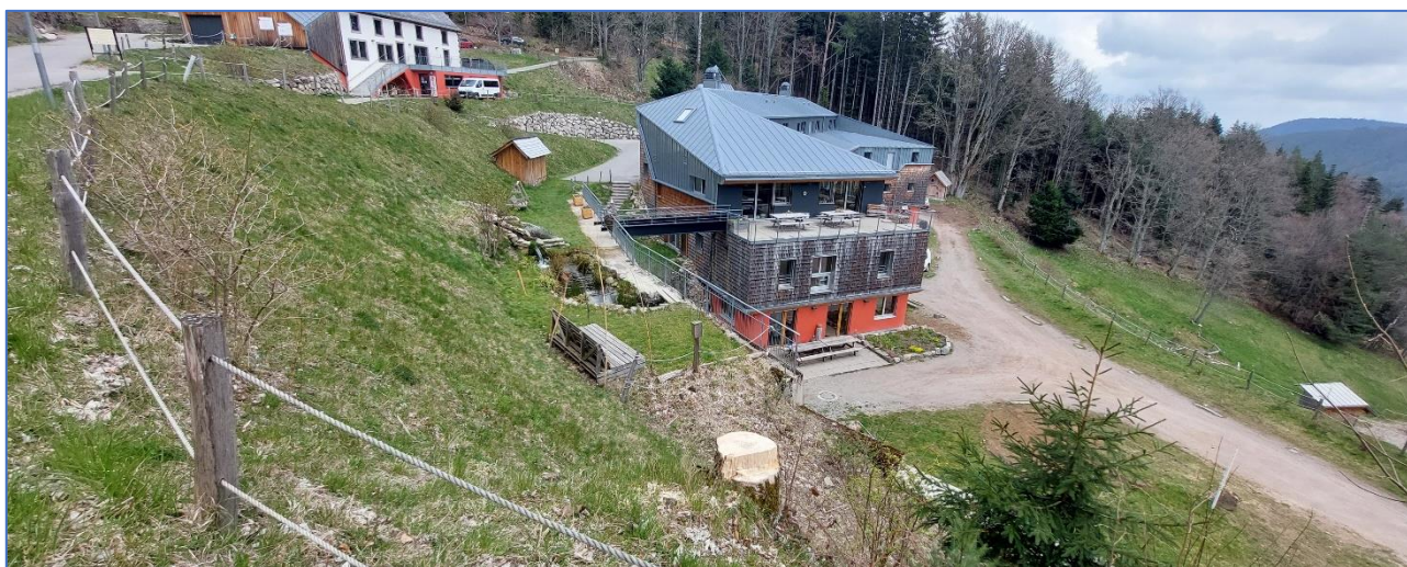
Vue depuis la voirie en amont du mur
