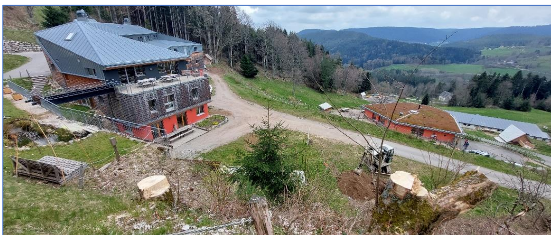
Photographie du site le 20/04/203 – vue depuis le haut du mur
