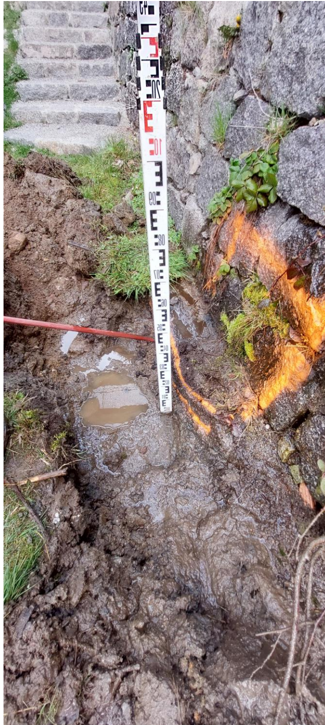
Vue de la fouille ouverte
