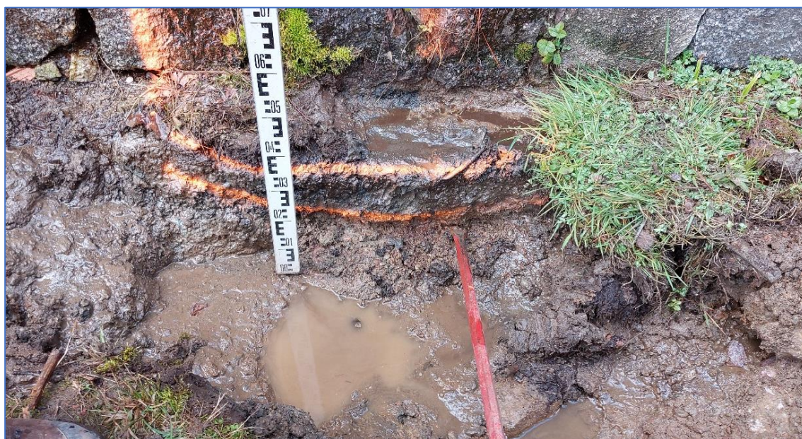
Photographies de la fouille RF2 le long du mur de soutènement
