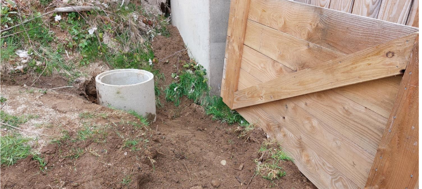
Vue de la fouille rebouchée
