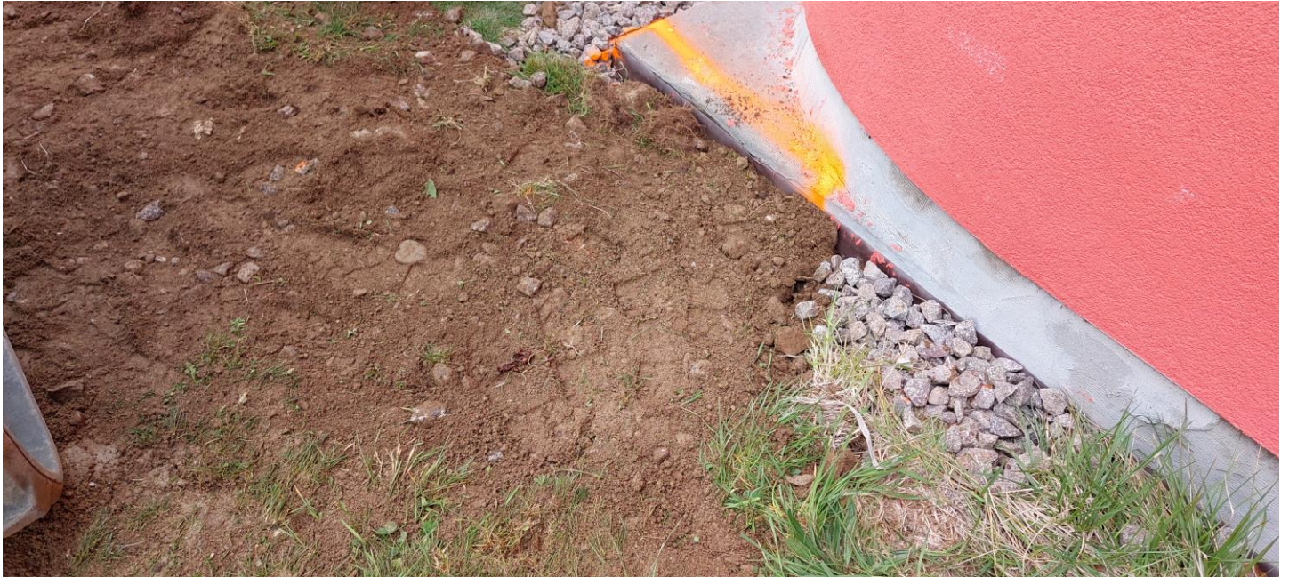
Vue de la fouille rebouchée
