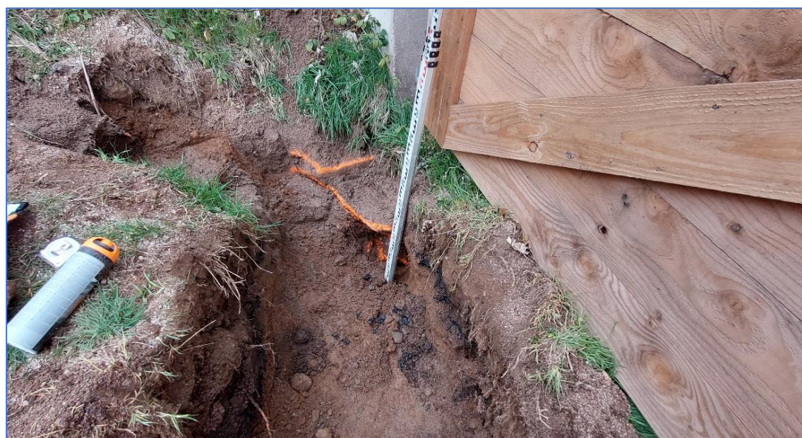
Photographies de la fouille RF3 au coin du mur de soutènement
