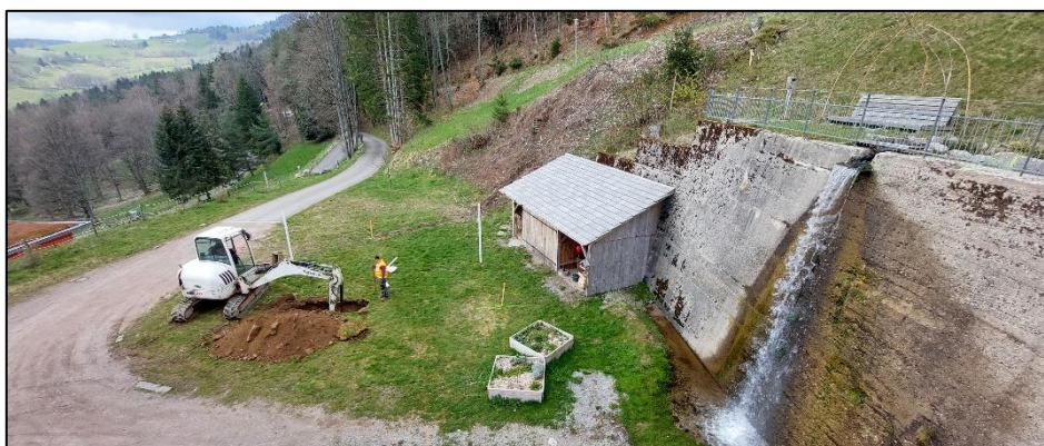
Gestion des eaux -mur de soutènement
