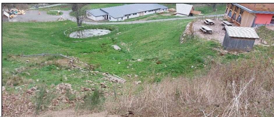
Gestion des eaux en aval du talus
