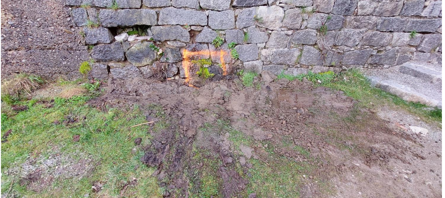
Vue de la fouille rebouchée
