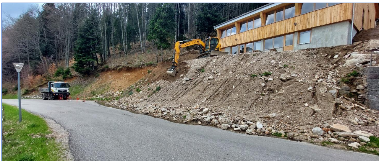
Construction d'un nouvel ouvrage et voirie existante en amont du projet
