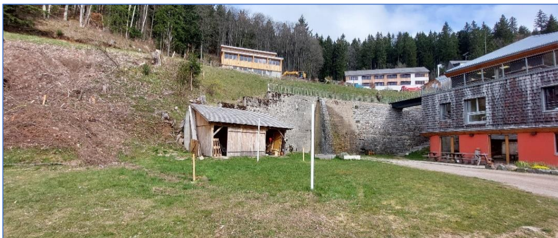
Photographie du site le 20/04/203 – vue depuis le bas du mur
