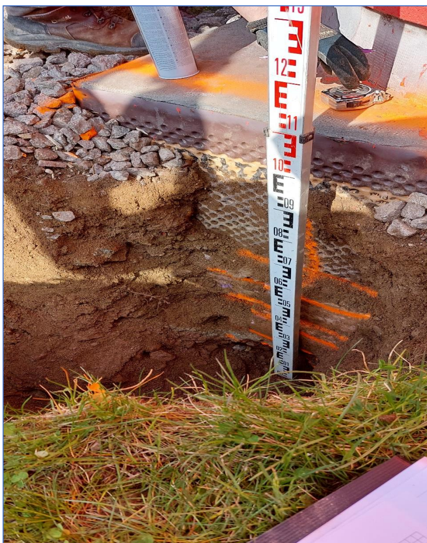
Photographie de la fouille des fondations du bâtiment existant
