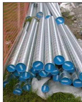
Stockage de gaines avec bouchons rigide
